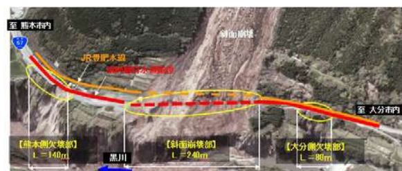
図表2 熊本地震で被災した国道57号
